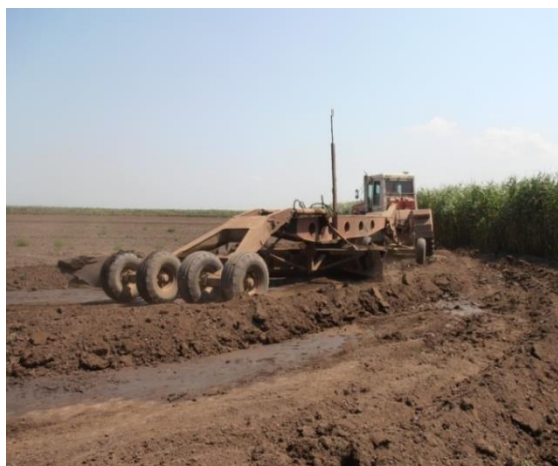
Рис. 2. Выравнивания угла чека клин-планировщиком
