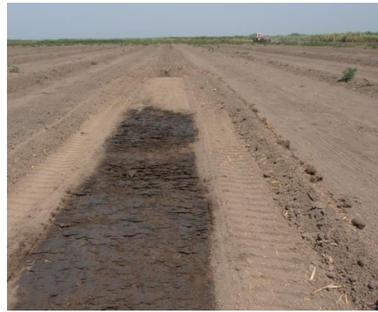
Рис. 4. Подбор насыпных валиков скрепером и транспортировка их в места микропонижений на чеке
