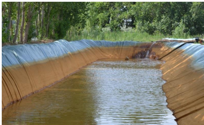
Рис. 2. Открытый водонакопитель системы комбинированного орошения
