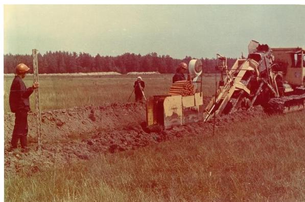
*Рисунок 4.11 – Строительство закрытого материального дренажа*
