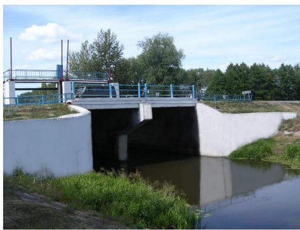
*Рисунок 4.17 – Шлюз-регулятор на р. Ясельде*
