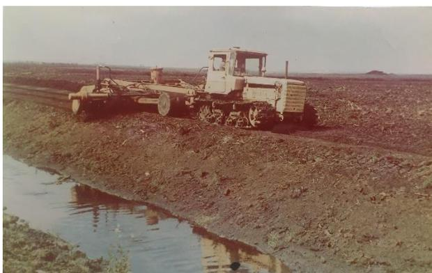
*Рисунок 4.10 – Строительство осушительного канала*
